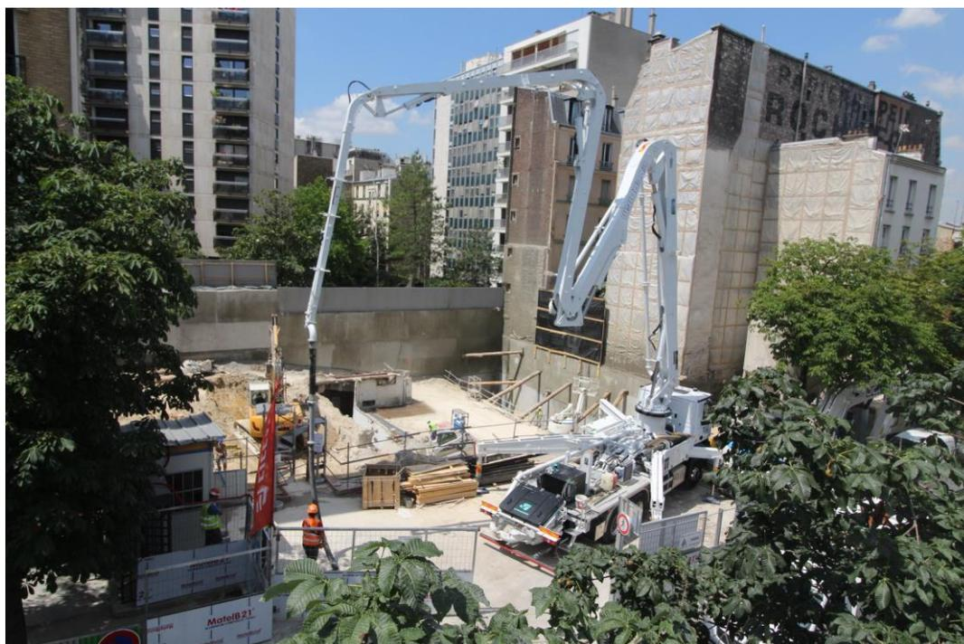
Pour creuser ces sous-sols, l'entreprise utilise un brise roches hydraulique, une pelleuse et son godet géant pour déverser les roches excavées dans des camions bennes stationnés en attente sur la piste cyclable devant le lycée Buffon et un projecteur à béton.
