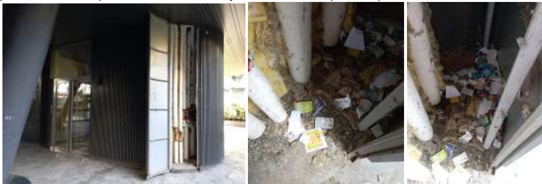
Gaine extérieure hall 4, ouverte...
